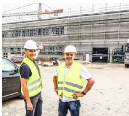
Auf der Baustelle: Andreas Maier (r.) gemeinsam mit Mario Köbe.
