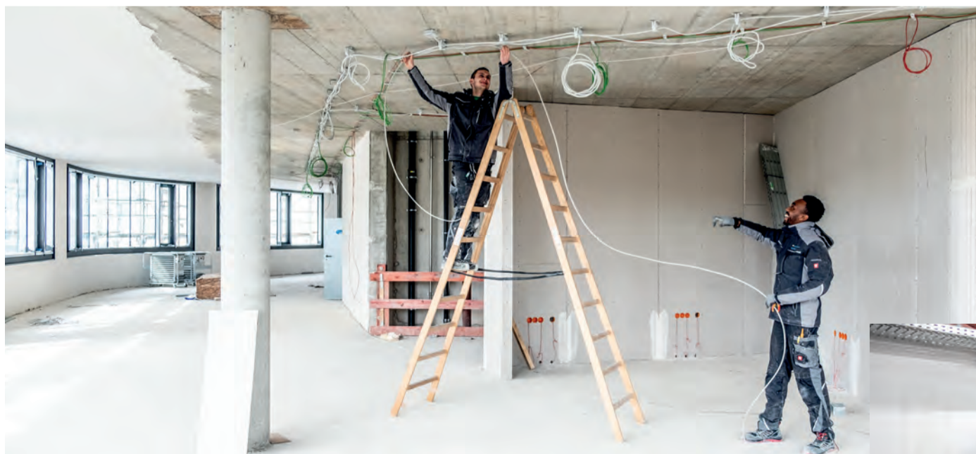
Allein auf weiter Flur: die Elektriker Krisztian Szenczi und Kevin Eboigbe beim Kabelziehen.
