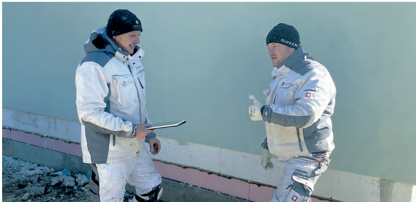
Volle Kontrolle: Für Daniel Rudolphs Mitarbeiter Michel Weiß (links) und Lars Müller gehört das Tablet inzwischen bei jedem Baustelleneinsatz dazu.
