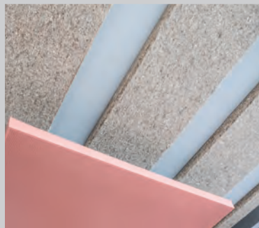
Raumakustische Maßnahme mit Hanffaser-Dämmplatten und Deckensegel.
