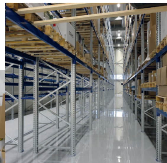
Bodenbeschichtung eines Hochregallagers ohne Störung des Betriebsablaufs beim Kunden: eine der Kernkompetenzen der Aalener Bauten- und Korrosionsschützer.
