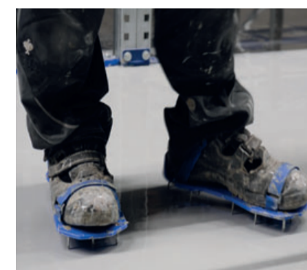
Der Catwalk ist die Baustelle.
