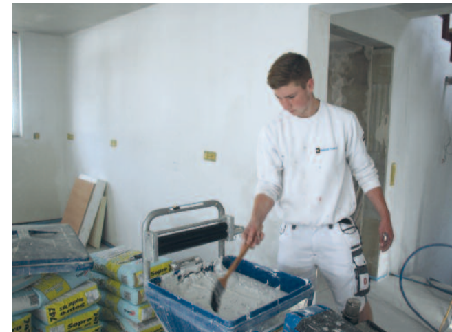
Hand in Hand: Azubi Daniel bedient im Erdgeschoss die Maschine, Roman trägt im Obergeschoss die Spachtelmasse auf.
