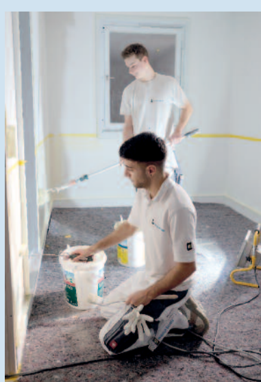
Vielseitiges Arbeiten im Baustellencamp.
