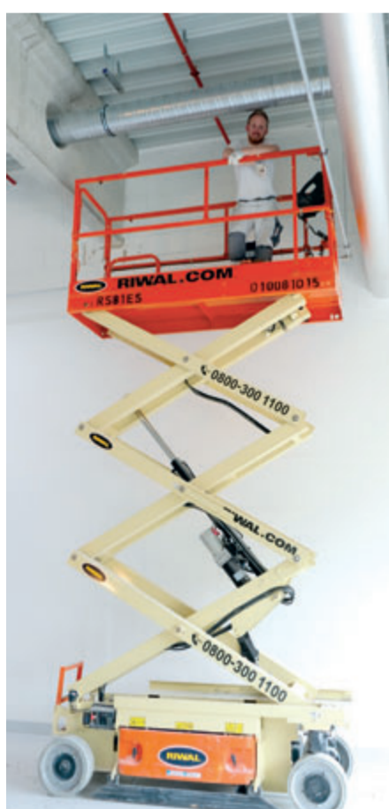
Hoch hinaus: Daniel Bühler beim Streichen von Rohrleitungen.
