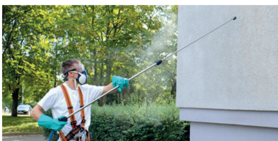
Untere Bereiche des Gebäudes in Plauen kann Fabrice Müller mit dem Teleskoprohr reinigen ...
