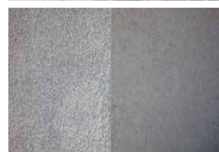
Mit einer Reliefwalze erzeugten die Stuckateure die grobe Struktur des Fassadenputzes.
