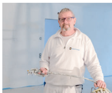
Das Leistungsspektrum reicht von klassischen Malerarbeiten bis zu Kreativtechniken. Auf der Baustelle in Kehl ist eher Ersteres gefragt. Udo Duss mit Airlesspistole.
