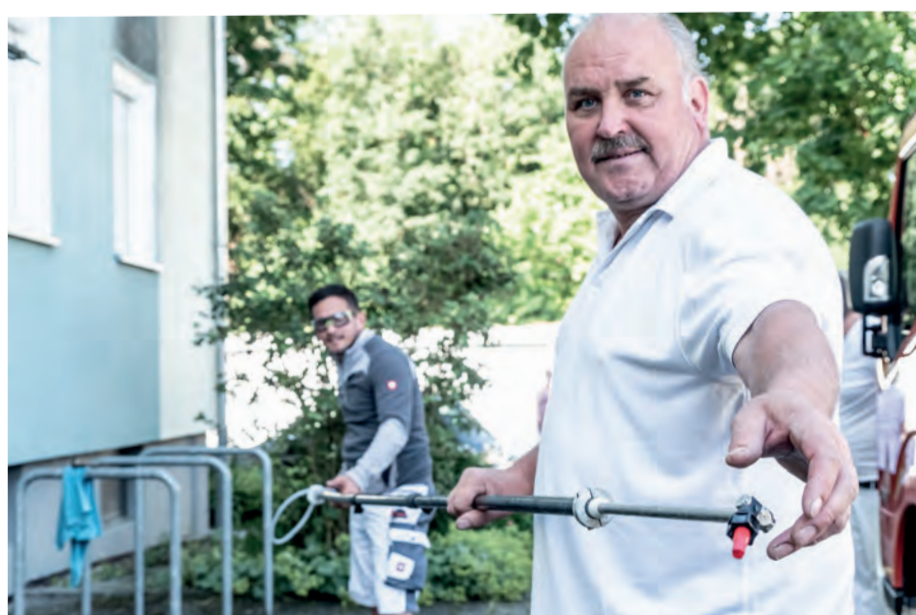
Fatih Zirih (l.) und Hans Wagner bei der Vorführung. Dank Arbeitsbühne und Teleskopverlängerung kann auf eine aufwendige Gerüststellung in den meisten Fällen verzichtet werden.
