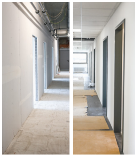
▲ Unter der Federführung vom Standort Zwickau übernahm der Standort Limbach-Oberfrohna die Trockenbauarbeiten und die Standorte Regensburg, Hof und Zwickau erledigten die Tapezier- und Malerarbeiten.
