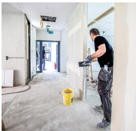
▲ In den Gebäuden wurden Wände abgerissen und neue Trockenbauwände gestellt.
