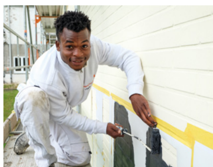
Ikram Karim, zweites Lehrjahr: „Hier arbeite ich das erste Mal mit Folie. Beim Ausmalen der Buchstaben muss ich drauf achten, dass auch die Fugen genug Farbe abbekommen.“
