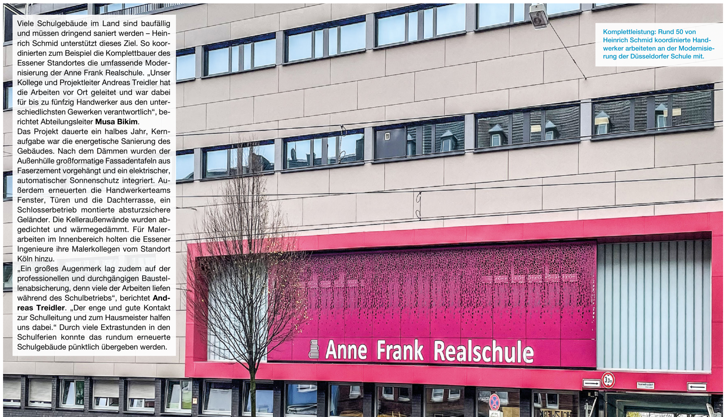
◀ Roter Rahmen: Der Fassadenteil um die Turnhallenfenster erhielt den Schriftzug der Schule und wurde als gestalterischer Akzent mit Alublech verkleidet, in das unzählige Löcher geschnitten sind.
