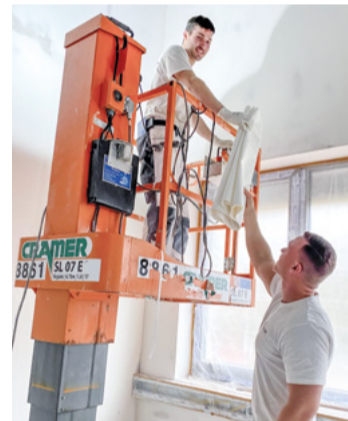
Handgriff für Handgriff: Jonat will als Geselle Baustellenerfahrung sammeln.
