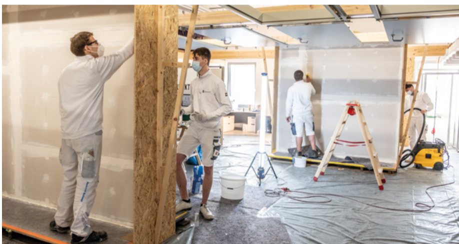
▲ Übungskojen bauen, mit Gipskartonplatten beplanken, spachteln, verputzen und streichen – das Wissensmodul „Trockenbau“ bringt den Gymnasiasten Theorie und Praxis näher.
