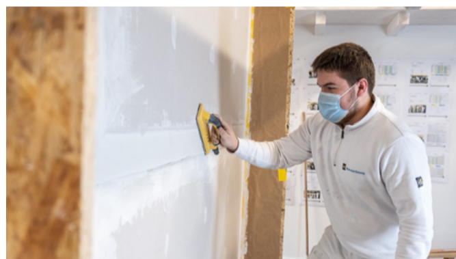
▲ Übungskojen bauen, mit Gipskartonplatten beplanken, spachteln, verputzen und streichen – das Wissensmodul „Trockenbau“ bringt den Gymnasiasten Theorie und Praxis näher.
