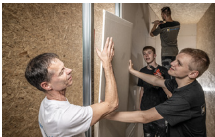
◀ Zuschneiden, Beplanken, Schrauben, Spachteln – und die Zusammenhänge verstehen: Mit Michael Försters Unterstützung lernen die Auszubildenden die Grundlagen im Trockenbau.
