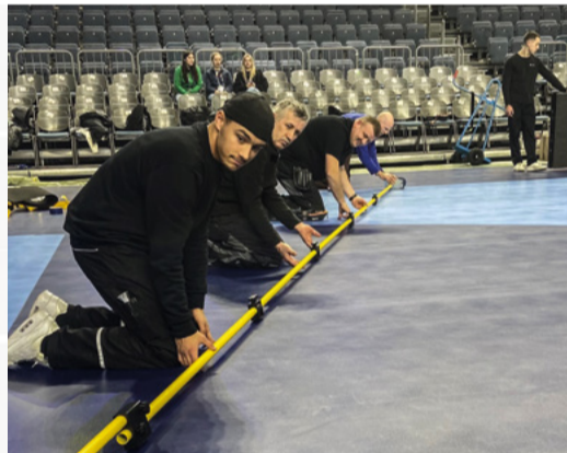
◀ Marke Eigenbau: Mit einer Art großem Zirkel und farbigem Klebeband brachte das Team die halbkreisförmigen Torraum-, Siebenmeter- und Freiwurflinien auf.
