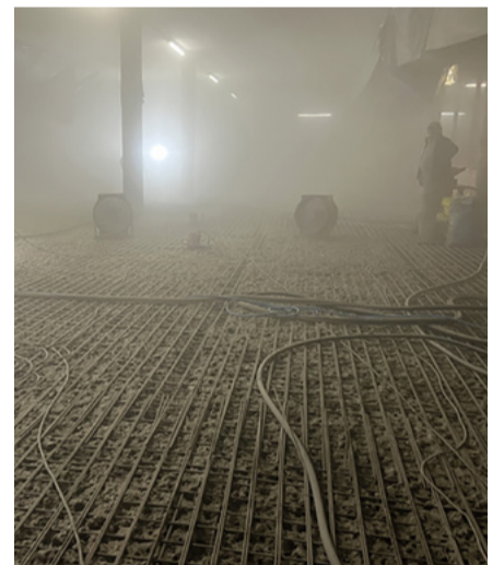
▲ Aufgrund des Feststoffstrahlens entstand viel Staub in der Luft und führte zu einer schlechten Sicht.
