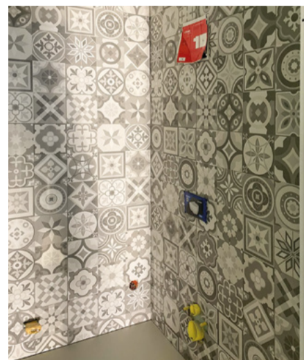
▲ Beispiele für Evars Qualitätsarbeit: Für ein sauberes Fugenbild müssen die Fugen fast unsichtbar sein.
