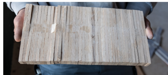
▲ Nach der aufwendigen Untergrundsanierung verlegen die Bodenleger aus Altbach Hochkantlamellen-Parkett aus Eichenholz.
