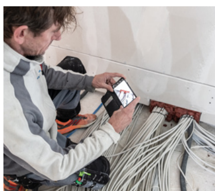
▲ Anto Petric dokumentiert die von ihm als Muster eingebauten Brandschutzschotts.
