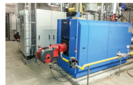
Effiziente Energieerzeugung mit Kraft-Wärme-Kopplung (KWK) und Gas-Brennkessel in einem Logistiklager in Heidelberg. Die Wärmeerzeugung erfolgt durch ein hocheffizientes Blockheizkraftwerk (BHKW). Es erzeugt neben Wärme auch Strom. KWK erreicht einen Gesamtwirkungsgrad von über 90 Prozent. Daneben werden eine Wärmepumpe und ein Gasbrennwertgerät betrieben. Vorteile sind unter anderem die Erfüllung der Richtlinien des Erneuerbare-Wärme-Gesetzes sowie die Reduzierung der CO 2 - und Feinstaubemissionen.
