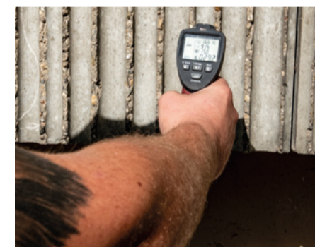
Vor der Sanierung waren Haftzugswerte und Karbonatisierungstiefen zu ermitteln, Schadstoffe zu analysieren und Schäden zu dokumentieren.
