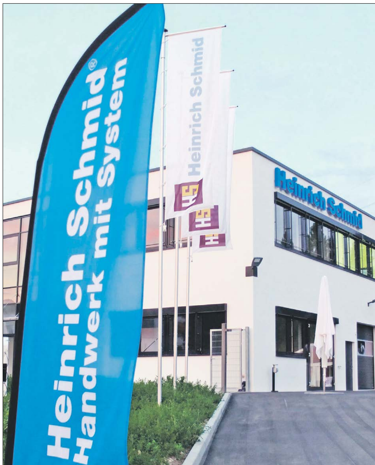
Der Neubau der Firma Heinrich Schmid in Altbach. Das Gebäude in den Weiden 9 ist nach neuesten Energiestandards gebaut und bietet durch versetzbare Wände maximale Flexibilität. Fotos: Konrad F. Gaag/ ReXCo Fotografie
